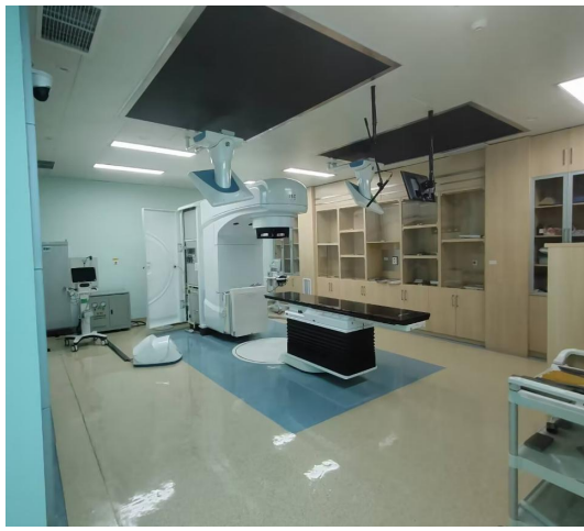
5号加速器机房室内
